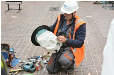
Trois avaloirs ont été équipés de filets permettant de récupérer les déchets (comme les mégots de cigarette) ainsi que de capteurs connectés pour suivre en temps réel leur niveau de remplissage grâce à une application mobile.
